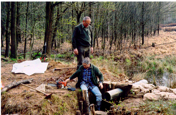
Grabenverschluss ©HR Agger-Sieg
